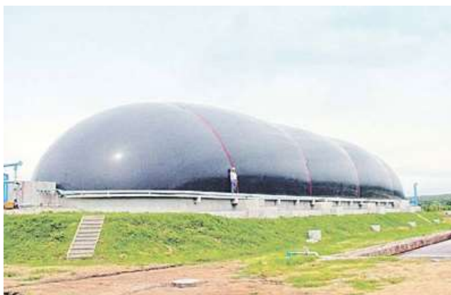
ภาพที่ 2.27 บ่อหมักก๊าซชีวภาพ ( https://www.siamchemi.com/ก๊าซชีวภาพ/ )
