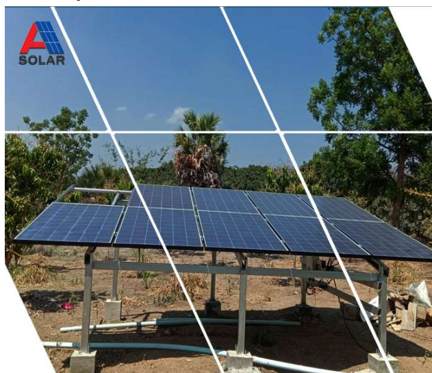
ภาพที่ 2.29 แผงโซลาร์เซลล์แบบยึดติดอยู่กับที่ (Fixed System)
