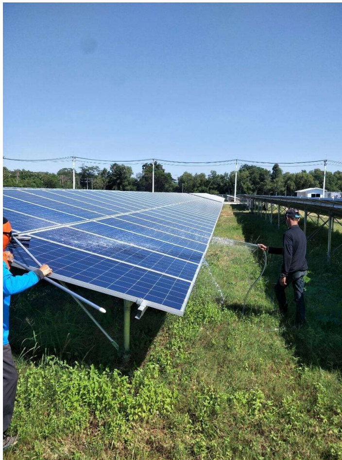
ภาพที่ 4.24 การทำความสะอาดแผง Solar Cell
