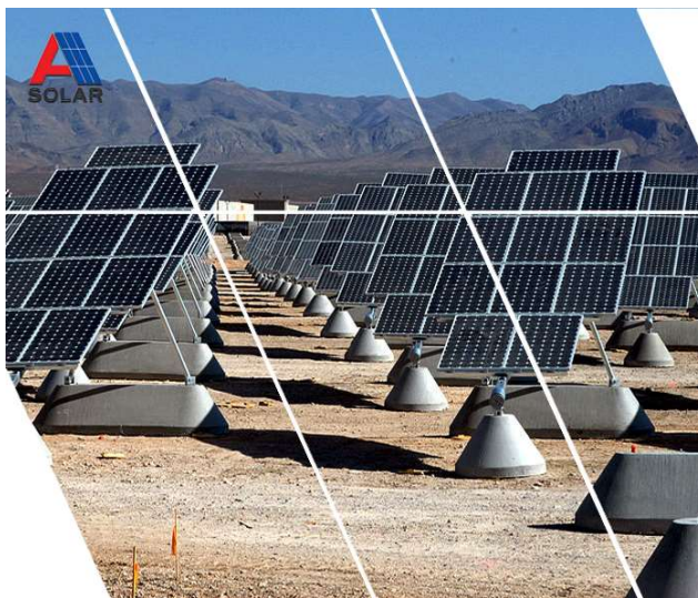
ภาพที่ 2.30 แผงโซล่าเซลล์แบบแบบหมุนตามดวงอาทิตย์ (Tracking System)
