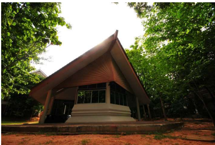
ภาพที่ 4.14 โครงการปรับปรุงเรียนและอาคารอเนกประสงค์ (อาคารสิม)
